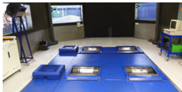
Instalaciones del banco de potencia 4x4 en Madrid
